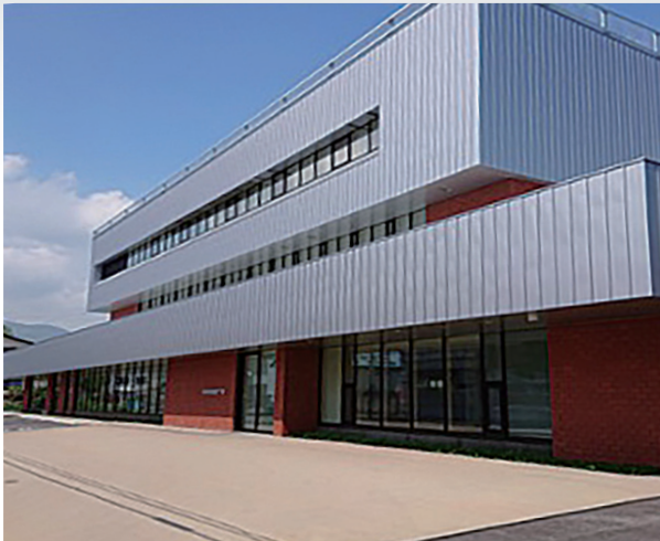
▲北海道ニセコ町役場庁舎はゼロエネルギー化を徹底。 高性能断熱材、木製トリプルガラス高性能窓を導入
